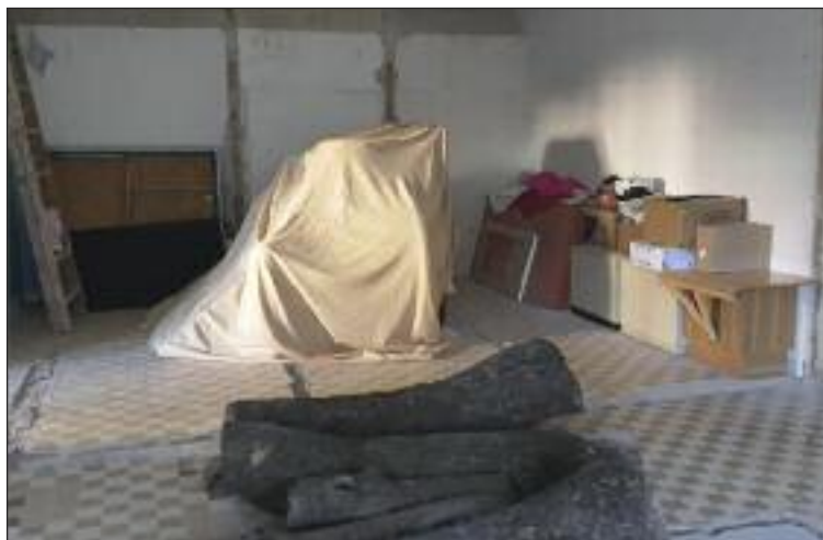
Dnes nevyužívané a zničené priestory na hornom poschodí Centra rodiny.
